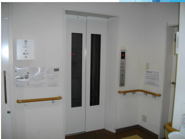
エレベーター
